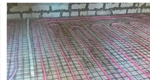
Опалення будинку з пінобетонних блоків, монтаж системи
