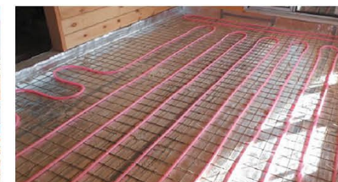
Опалення будинку з бруса, монтаж системи
