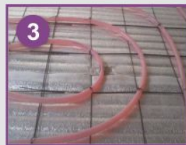
Покладіть арматурну сітку та закріпіть трубу
