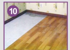
Покладіть підлогове покриття
