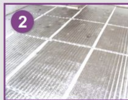
Покладіть теплоізоляцію
